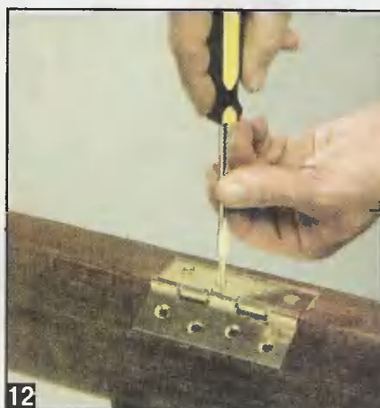
12 Просверлила по разметке направляющие отверстия диаметром несколько меньшим диаметра шурупа, петлю крепят окончательно.
