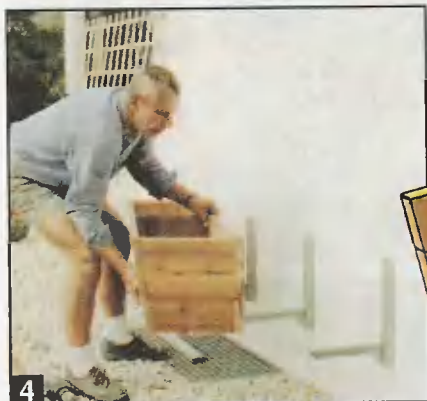
4 Устанавливают цветочный ящик на кронштейны, примеряют положение решетки на стене, временно фиксируя ее каким-либо способом.
