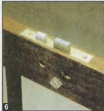
6 Вставив на место и закрепив замок шурупами, проверяют легкость его открывания-закрывания ключом и ручкой.
