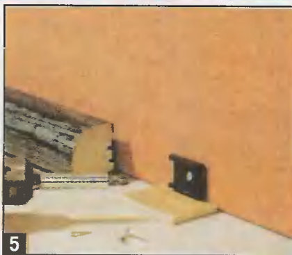
5 Точно расположить кляммеры для крепления плинтуса по высоте помогают дистанционные прокладки.
