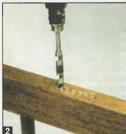
2 Для облегчения выборки древесины в дверном полотне сверлят ряд отверстий.
