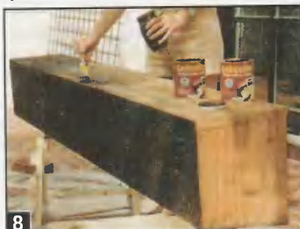
8 Покрытие цветочного ящика и деревянной решетки антисептирующим декоративным составом типа «Пинотекс» повышает долговечность конструкции.
