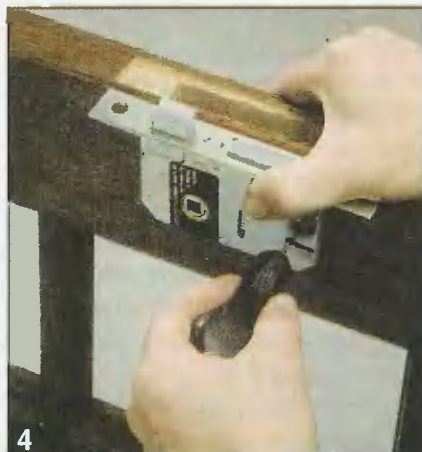
4 Сделав выборку под лицевую пластину, длинным и тонким шилом намечают центры отверстий под ключ и ручку замка.
