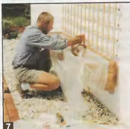
7 Ящик изнутри выкладывают полиэтиленовой пленкой, прикрепляя ее края к стенкам при помощи степлера. В пленке проделывают дренажные отверстия.
