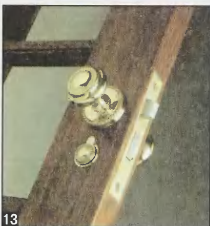
13 Фурнитуру замка (ручку, ключевину) можно установить до навески двери в коробку.
