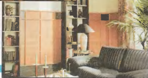
Рис. 4. Панелями можно обшивать и поверхности выступающих углов. Стыки между панелями закрывают планками-нащельниками.
