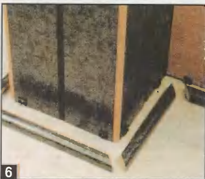
6 Плинтусы, прикрепляемые вокруг обеих колонн, необходимо точно раскроить по длине с запиливанием «на ус» их торцов.
