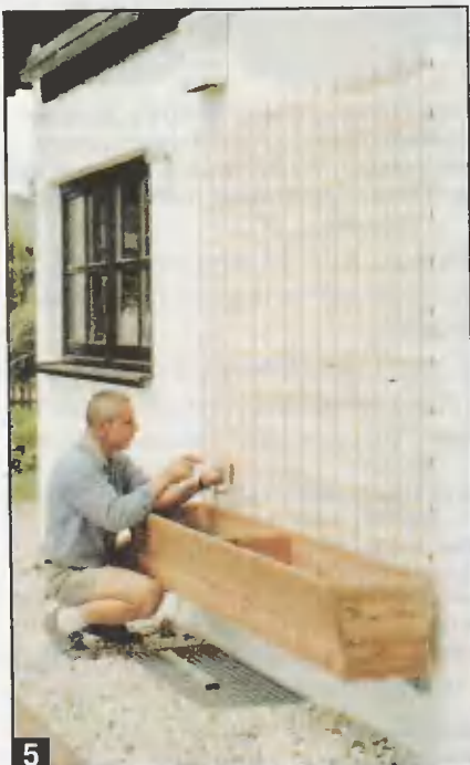
5 Разметив положение дюбелей для крепления решетки точно в ее узлах, под них сверлят отверстия.
