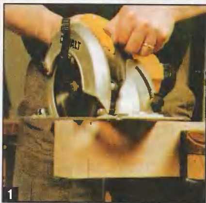
1 Запечки шипов запиливают циркулярной пилой.
