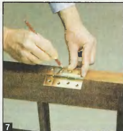
7 Приложив дверную петлю на место крепления, карандашом обводят ее карту.
