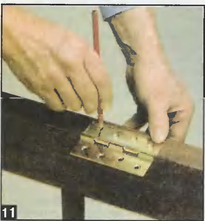
11 Приложив петлю на место, отмечают положение шурупов крепления.
