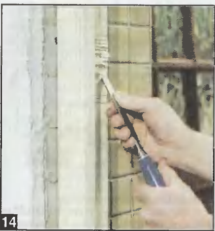
14 Для навески двери в коробку нужно подготовить посадочные места для петель. ▣
