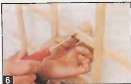
6 Решетку прикрепляют к стене с применением дистанционных бобышек, заворачивая шурупы-саморезы в дюбели.
