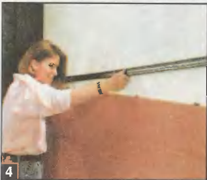
4 Простейший вариант завершения обшивки стены – установка декоративной планки.
