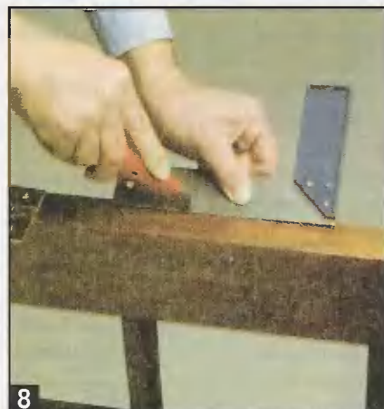
8 По линии разметки петли ножом-косячком делают надрез глубиной около 2 мм.
