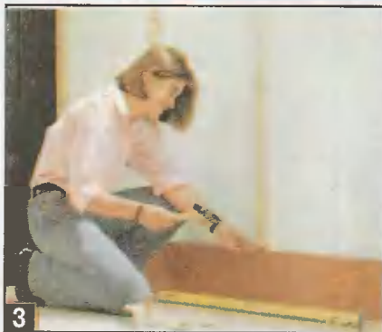
3 На стены панели устанавливают горизонтально, не нарушая при этом основного принципа монтажа.
