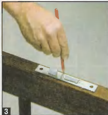
3 После выборки древесины в образованный паз аставляют корпус замка и размечают положение его лицевой пластины.
