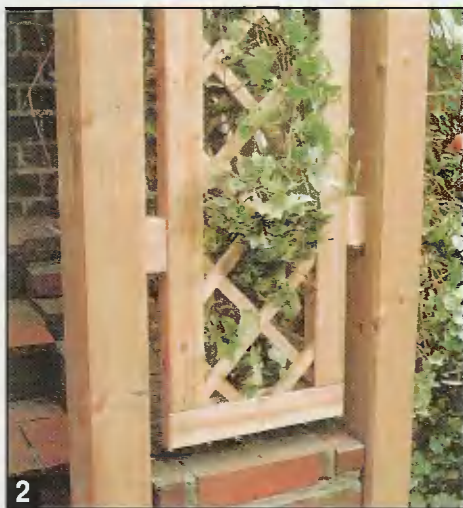
2 Декоративные решетки установлены между столбами враспор при помощи дистанционных бобышек и саморезов.
