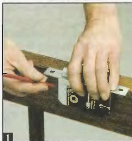
1 Приложив замок к дверному полотну в месте его врезки, размечают положение выборки под корпус замка.
